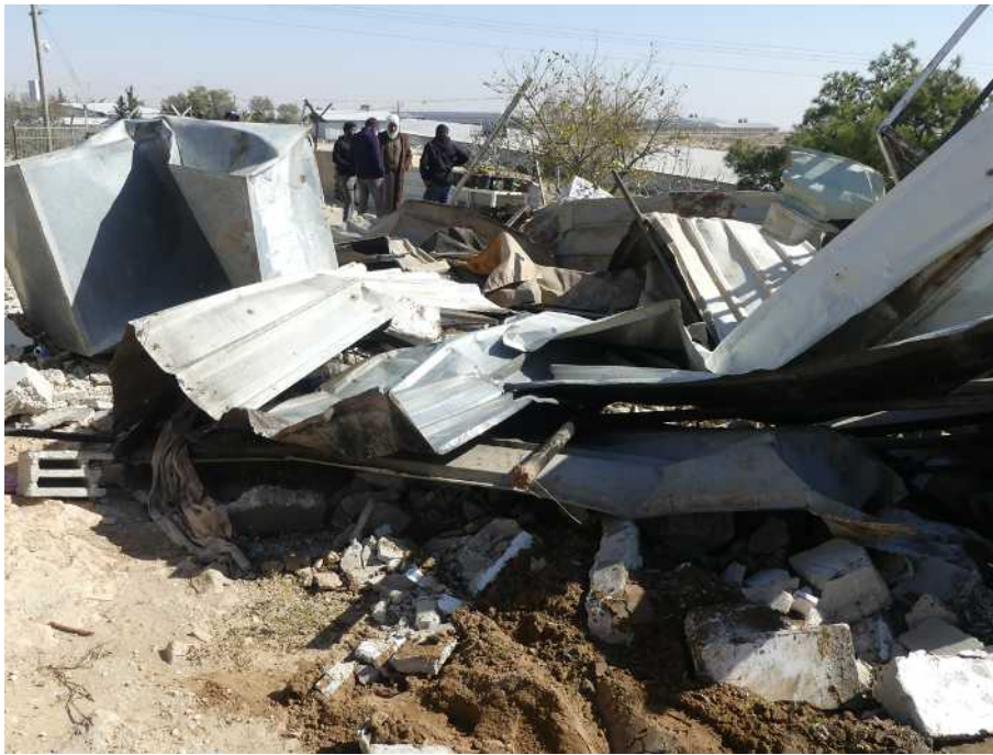
Figura 4.6: Umm al Kheir, 19 febbraio. Le rovine di una casa palestinese appena demolita.
