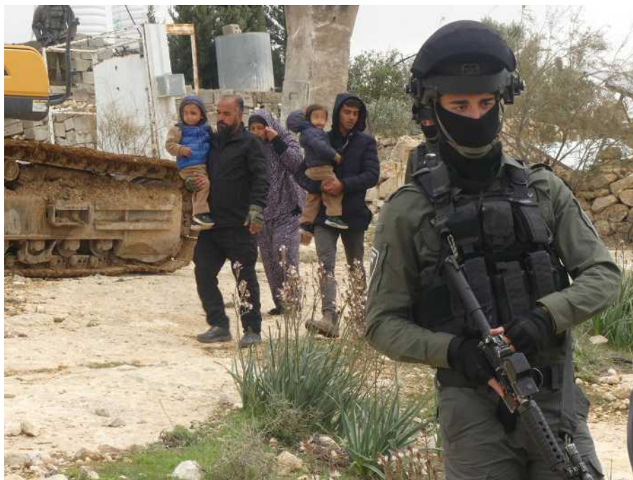
Figura 4.11: Khallet Athaba', 10 febbraio. Una famiglia palestinese è costretta a lasciare la propria casa che sta per essere demolita.
